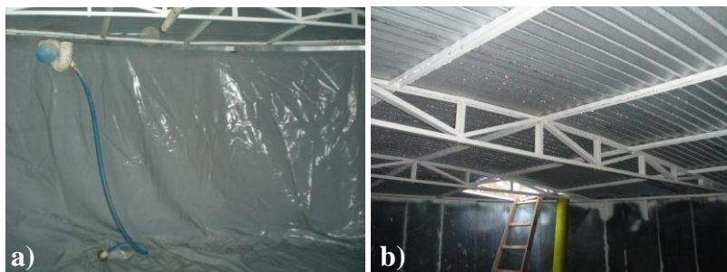
Figura 51: a) geomembrana de PVC; b) cobertura metálica.
