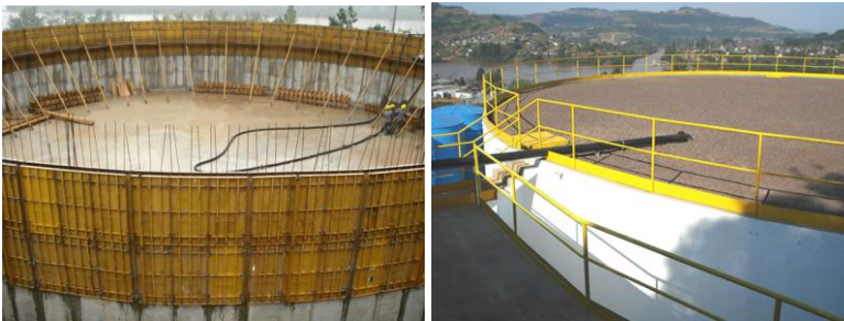
Figura 14: Reservatório em concreto armado.
