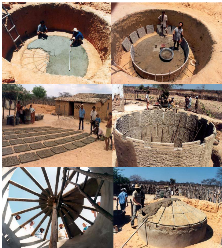
Figura 13: Método construtivo da cisterna de placas. Fonte: ASA BRASIL (2009).
