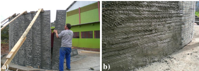
Figura 54: a) montagem das placas de ardósia; b) armadura e argamassagem manual.
