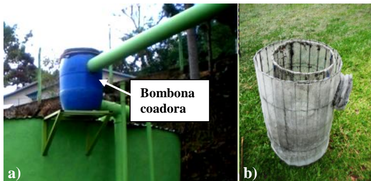
Figura 25: a) Bombona Coadora; b) telas para retenção dos resíduos.
