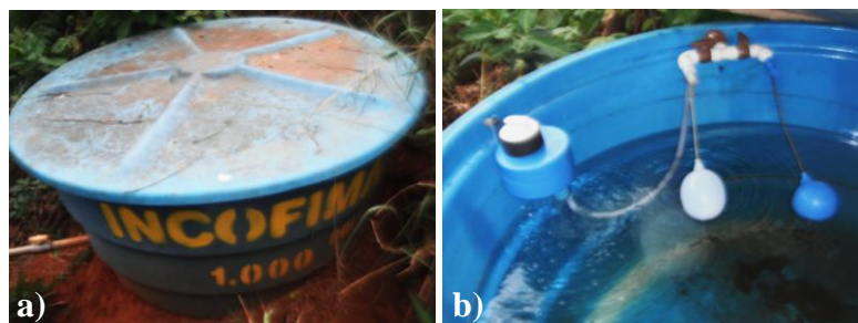
Figura 66: a) reservatório intermediário; b) dispositivo de desinfecção Mega Clorador.
