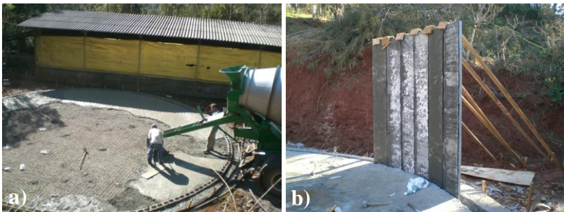
Figura 59: a) execução da base de concreto armado; b) montagem das placas de ardósia.
