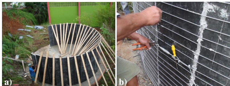
Figura 50: a) montagem das placas de ardósia; b) cabos de aço.
