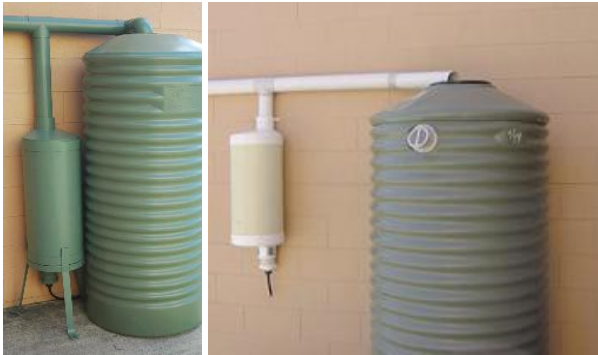
Figura 9: Dispositivos de desvio das águas das primeiras chuvas do tipo bóia flutuante.
