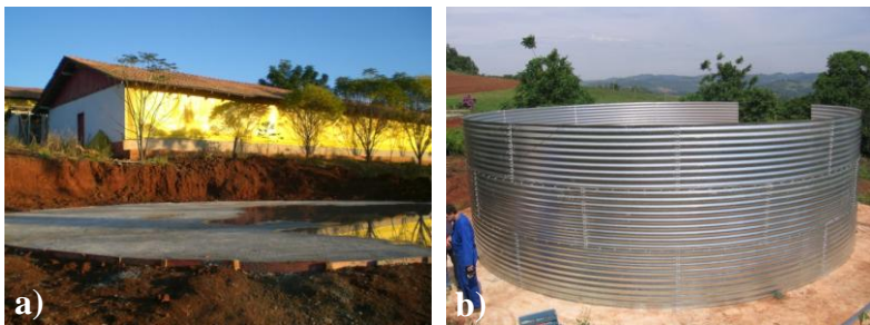
Figura 63: a) base de concreto armado; b) montagem das chapas de aço galvanizado.
