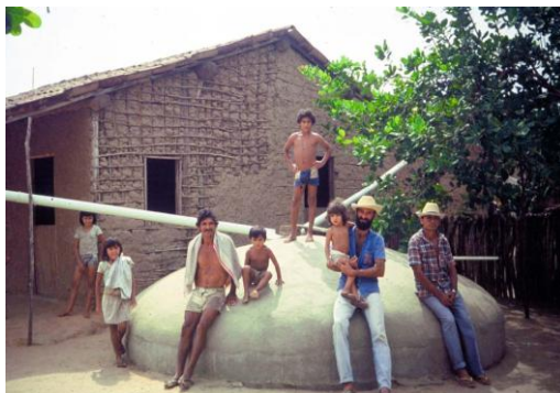
Figura 15: Reservatório em ferro-cimento construída no Nordeste Brasileiro.
