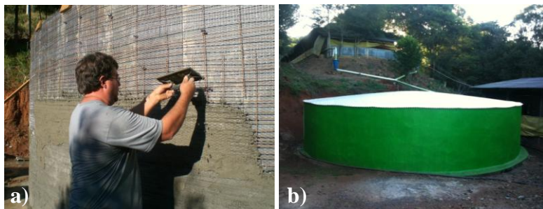
Figura 60: a) camada estrutural; b) vista geral do reservatório.
