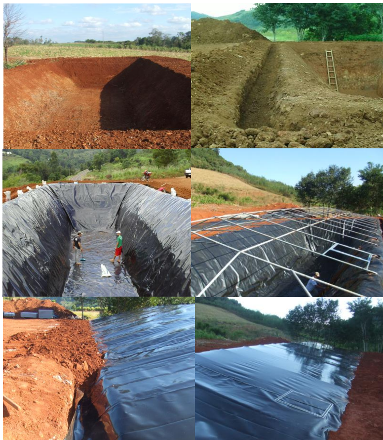
Figura 18: Etapas construtivas da cisterna em geomembrana de PEAD. Fonte: BIOTER (2010).
