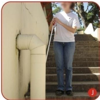
Figura 83 – Ponto J na Figura 87 – Tubulação aparente atrapalha deslocamento da aluna em escada externa ao Bloco B
