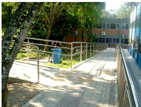
Figura 72 - Alternância de sombra e sol faz desaparecer contraste de cor dos pisos direcionais com o adjacente
