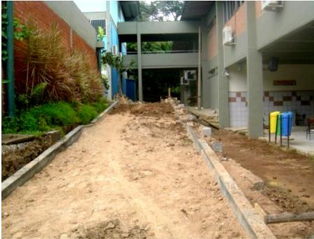
Figura 62 – Aterro construído para alargar o caminho entre o Bloco A e os Blocos C (na cor azul, ao fundo e à esquerda) e D (à direita)
