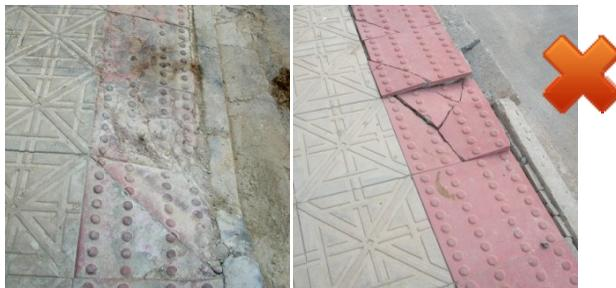
Figura 47 – Pisos desgastados e quebrados não desempenham sua função
