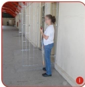
Figura 82 – Ponto I na Figura 87 – Grade de proteção em porta de sala do Bloco B atrapalha o deslocamento da aluna cega
