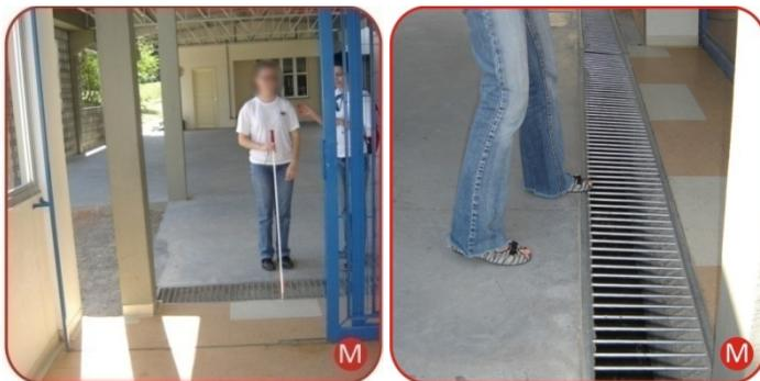
Figura 85 - Ponto M na Figura 87 – Grelha em desacordo com a NBR 9050/2004 na conexão entre os Blocos B e A
