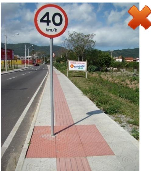
Figura 49 – Piso alerta colocado no meio de uma rota de piso direcional para indicar uma placa de sinalização disposta também de maneira errônea
