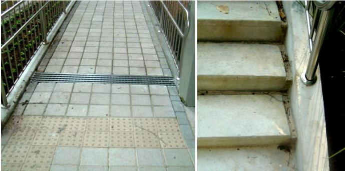
Figura 74 – Detalhes construtivos para facilitar a drenagem
