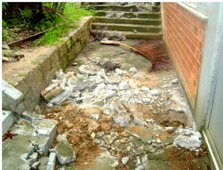
Figura 57 – Piso em concreto existente teve que ser quebrado para colocação dos pisos intertravados
