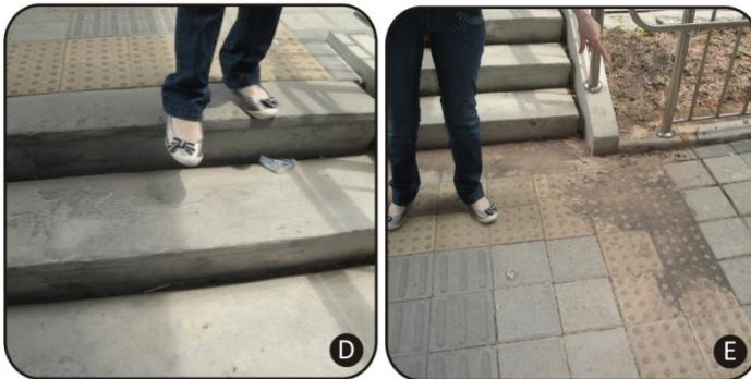
Figura 90 - Pontos D e E na Figura 95 – Acesso ao Bloco D: falta de contraste de cor nas bordas dos degraus e sujeira no piso atrapalham a orientação da aluna de Filosofia
