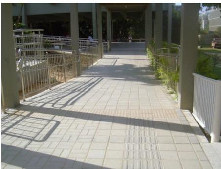
Figura 71 – Alternância de sombra e sol faz desaparecer contraste de cor dos pisos direcionais com o adjacente
