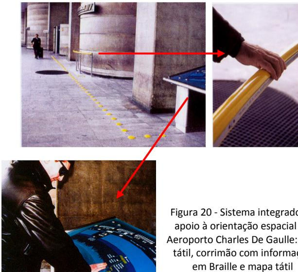
Figura 20 - Sistema integrado de apoio à orientação espacial no Aeroporto Charles De Gaulle: piso tátil, corrimão com informação em Braille e mapa tátil
