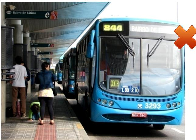
Figura 46 – Piso alerta colocado no TICEN, em Florianópolis (SC), ao invés de indicar o perigo da plataforma, segue de guia para a fila dos ônibus
