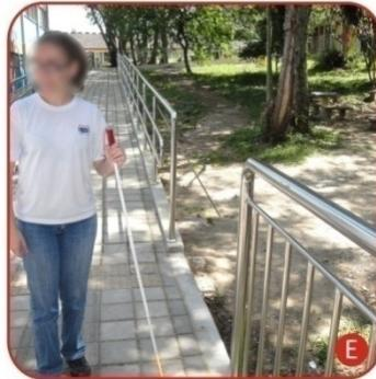
Figura 79 – Ponto E na Figura 87 – Interrupção do guarda-corpo em local onde o terreno não recebeu aterro gera situação de perigo à aluna
