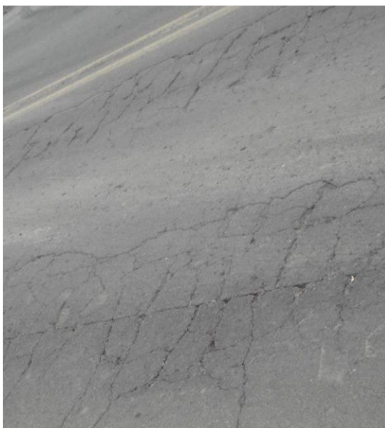
Figura 72 Trincas interligadas
