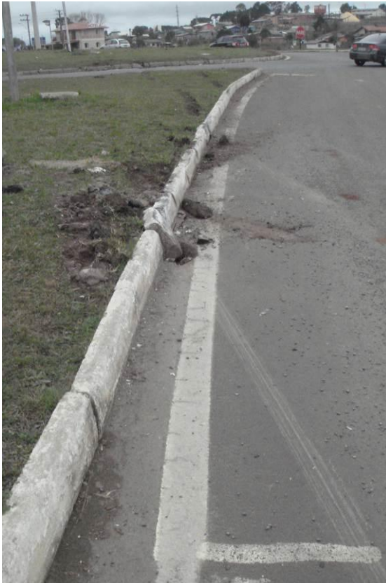
Figura 75 Marcas de frenagem
