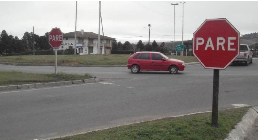
Figura 63 Sinalização vertical (R-1) aproximação da BR282 – não preferencial
