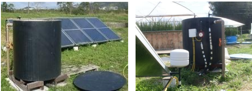
Figura 09: Reator de desinfecção de lodo.
