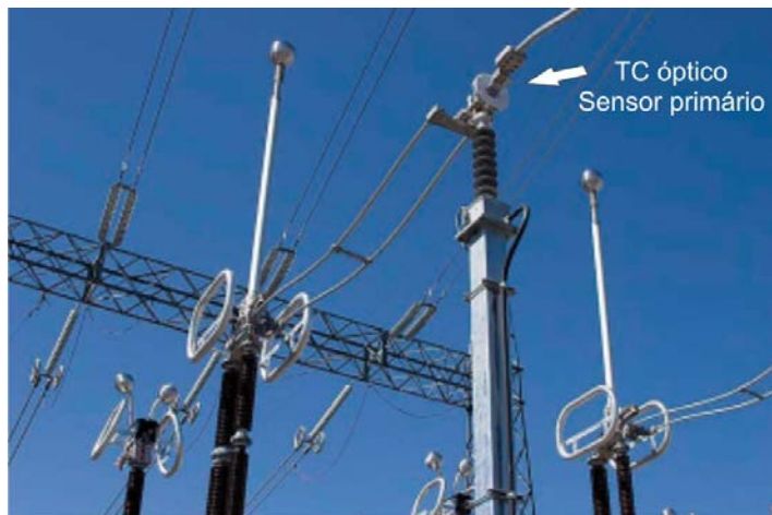
Figura 6 - TC óptico do fabricante NXT Phase .
