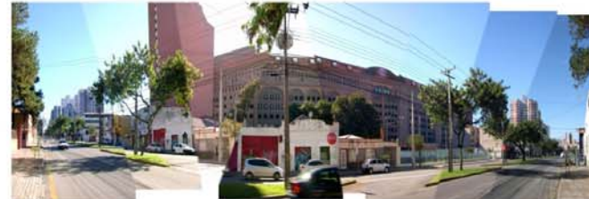
17. Av. Silva Jardim,faixada posterior do Shopping Estação. Fonte: HFA, 2010.
