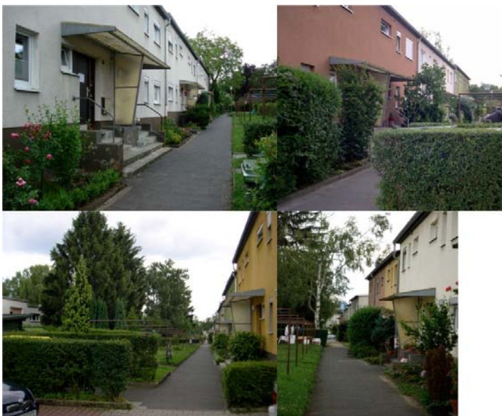
Figura 93 - Siedlung Westhausen, Frankfurt - Alemanha - 1929-1931
