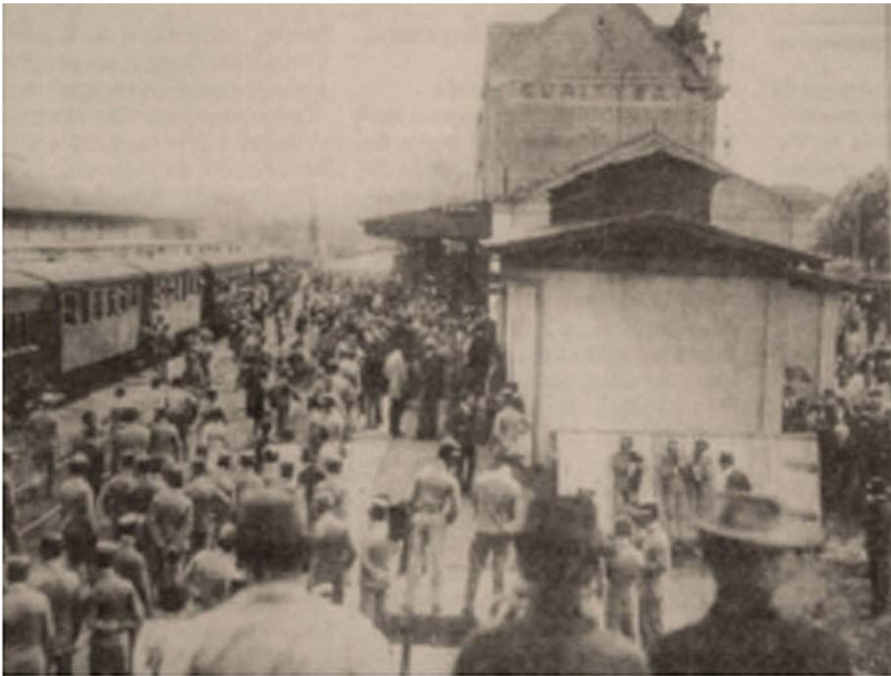
Figura 23 - Vista da Estação Ferroviária de Curitiba na década de 1940
