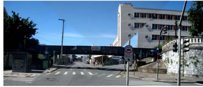
12. Vista da Ponte Preta sobre a Rua João Negrão. A ponte foi tombada pelo Estado do Paraná em 1976. Tornou-se obsoleta em função da desativação da estrada de ferro. Encontra-se em meio aos terrenos ociosos remanescentes da rede ferroviária. Fonte: HFA, 2011.
