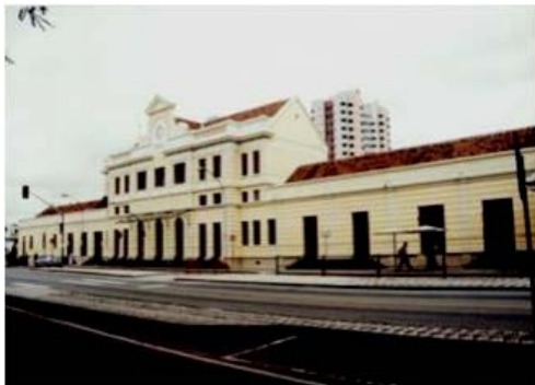
Figura 6 - Estação ferroviária de Curitiba após a conclusão das obras de intervenção
