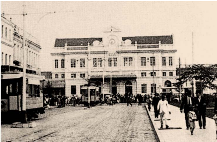
Figura 21 - Estação ferroviária após a ampliação, em abril de 1916 Fonte: Duarte e Guinski (2002, p.83)
