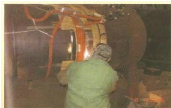
Figura 3.27 – Sistema de aquecimento por indução utilizado durante a soldagem do Trans-Alaska. (BRUCE, 2004).
