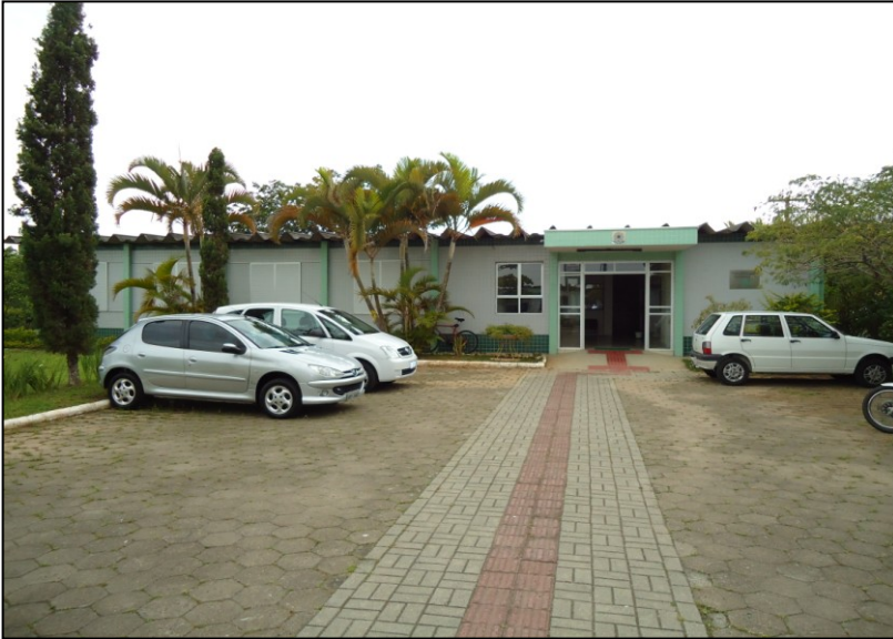
Figura 16 – Fachada da edificação B.
