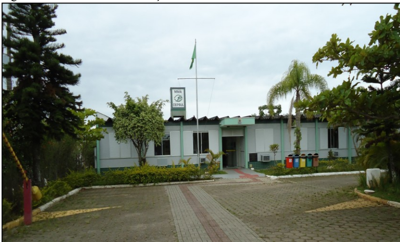
Figura 13 – Fachada da edificação A.
