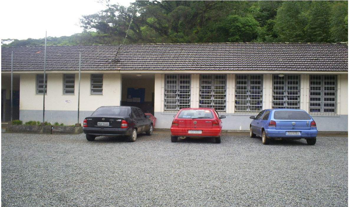
FOTO 2: FRENTE DA ESCOLA, BEM NO CENTRO.
