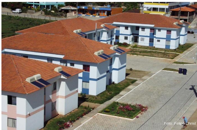
Figura 3.1 - Vista parcial dos aquecedores solares do Solar Buona Vita (Fonte: Relatório Final - P&D LABSOLAR/NCTS/Celesc, 2004)
