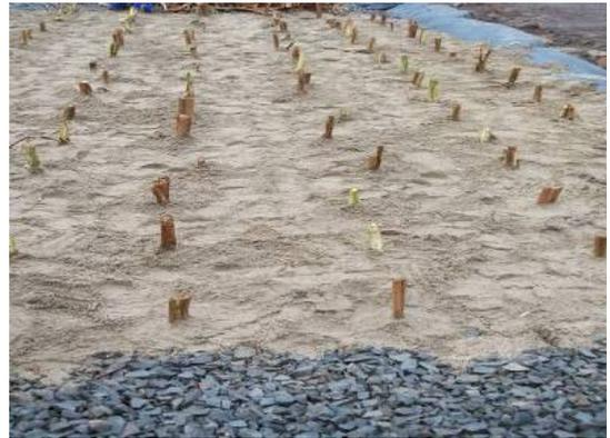
Figura 8: Filtro plantado com as mudas aparadas
