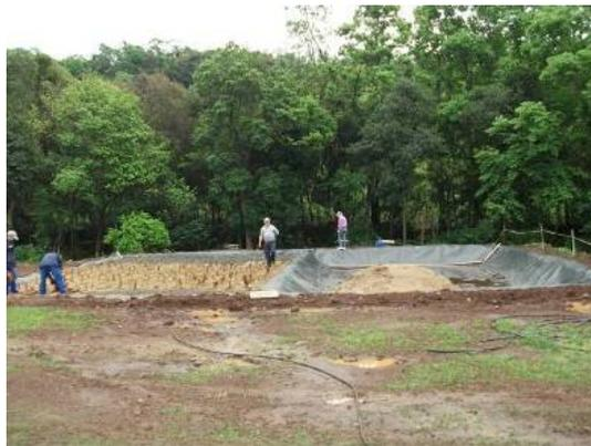
Figura 4: Filtro 1 e Filtro 2 em fase de acabamento
