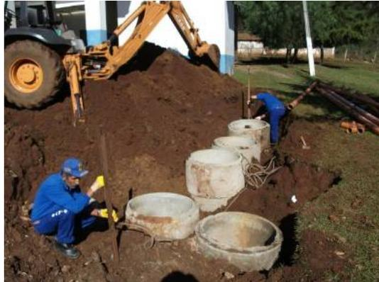
Figura 2: Construção das tanques e filtros anaeróbios
